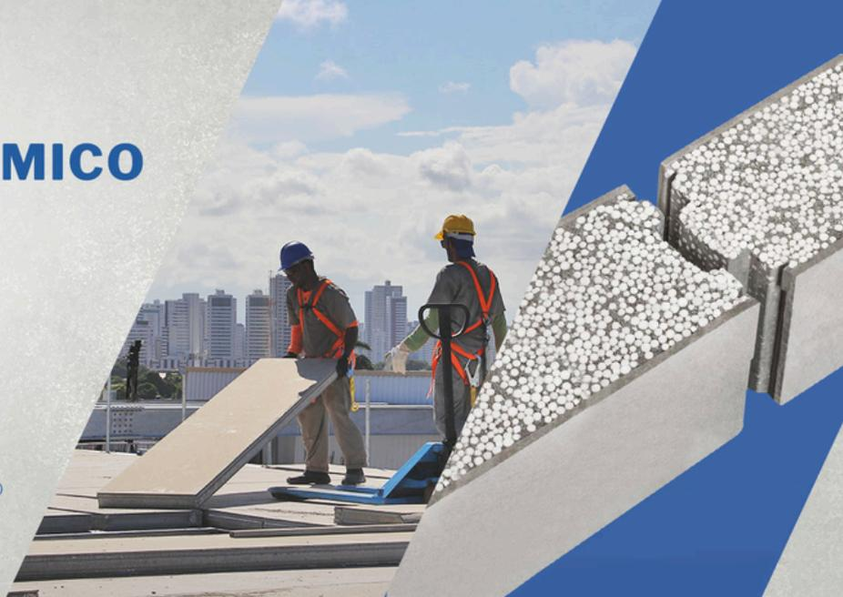
O LIGHTWALL É UM SISTEMA DE CONSTRUÇÃO MODULAR INOVADOR COMPOSTO POR PAINÉIS LEVES DE CONCRETO. ESSES PAINÉIS SÃO FABRICADOS UTILIZANDO CHAPAS CIMENTÍCIAS E UM NÚCLEO DE CIMENTO PORTLAND COMBINADO COM PÊROLAS DE EPS (POLIESTIRENO EXPANDIDO). ELES SÃO CONHECIDOS POR SUA LEVEZA, DURABILIDADE E EFICIÊNCIA ENERGÉTICA.
